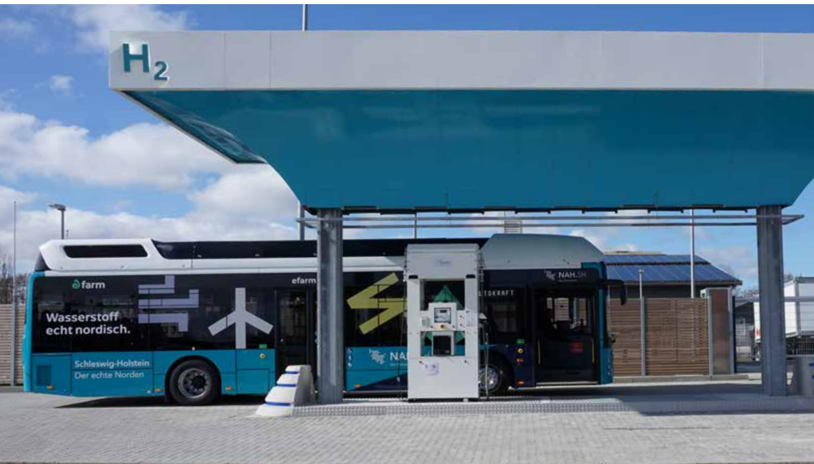
Wasserstofftankstelle in Niebüll, Nordfriesland, GP JOULE >
