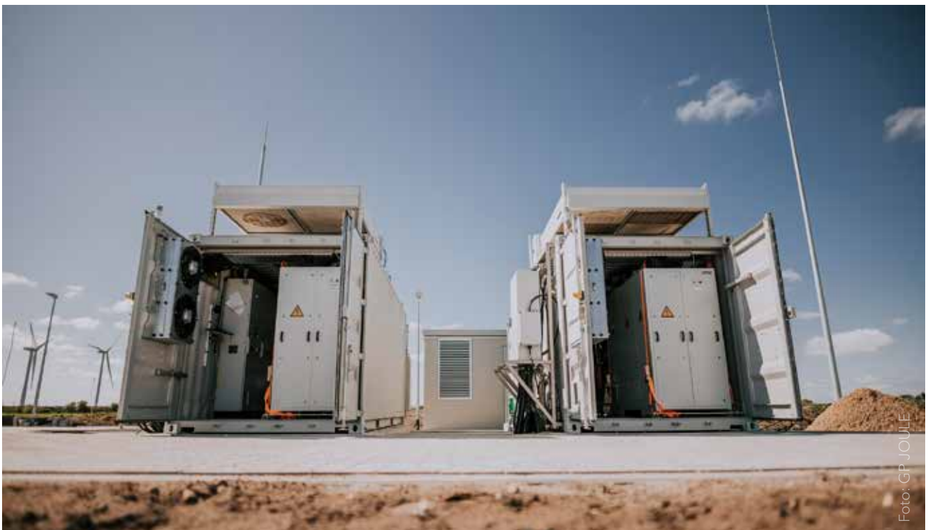
H2 erzeugen: Elektrolyse/Verdichtung am Windpark, GP JOULE
